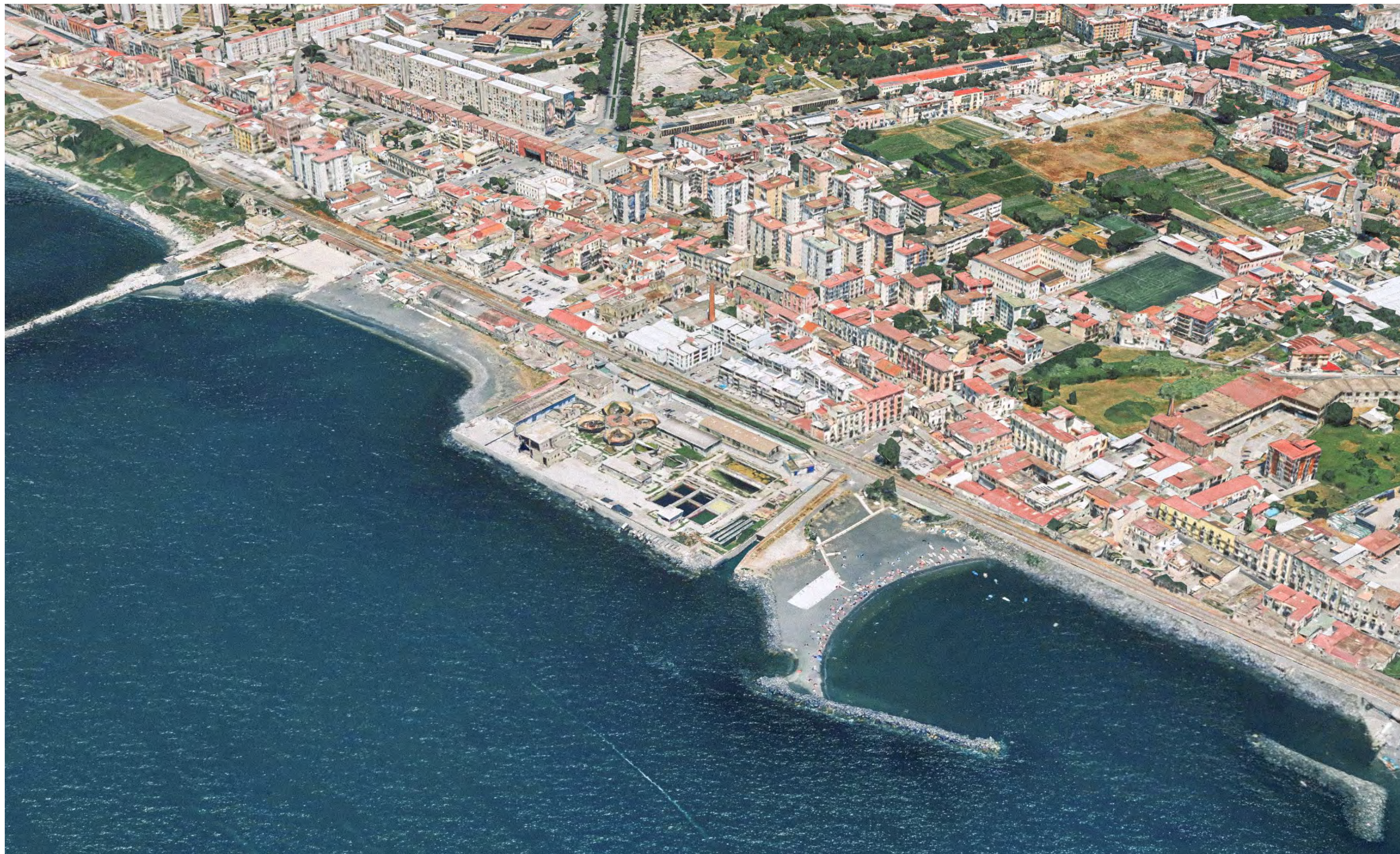
Ex depuratore idrico e arenile di San Giovanni a Teduccio
