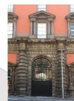
Fig. 11 - Prospetto da via Santa Teresa degli Scabi
