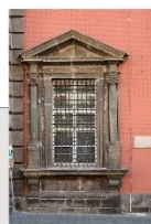
Fig. 6 - Prospetto da via Santa Teresa degli Scabi
