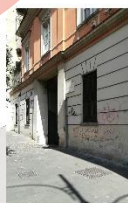
Fig. 5 - Prospetto da via Santa Teresa degli Scabi
